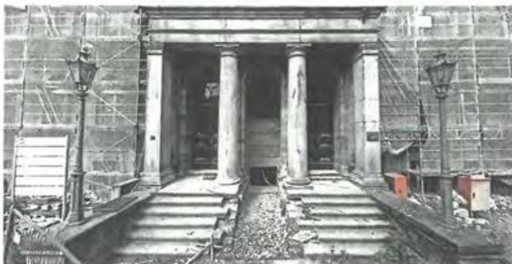
Die Arbeiten am „Forum Wissen“ der Universität Göttingen schreiten voran: Nicht allen gefällt das. Der Geschichtsverein Göttingen hat erneut die „Zerstörung“ des Eingangsportals des denkmalgeschützten Gebäudes kritisiert. FOTO: WOLTER
